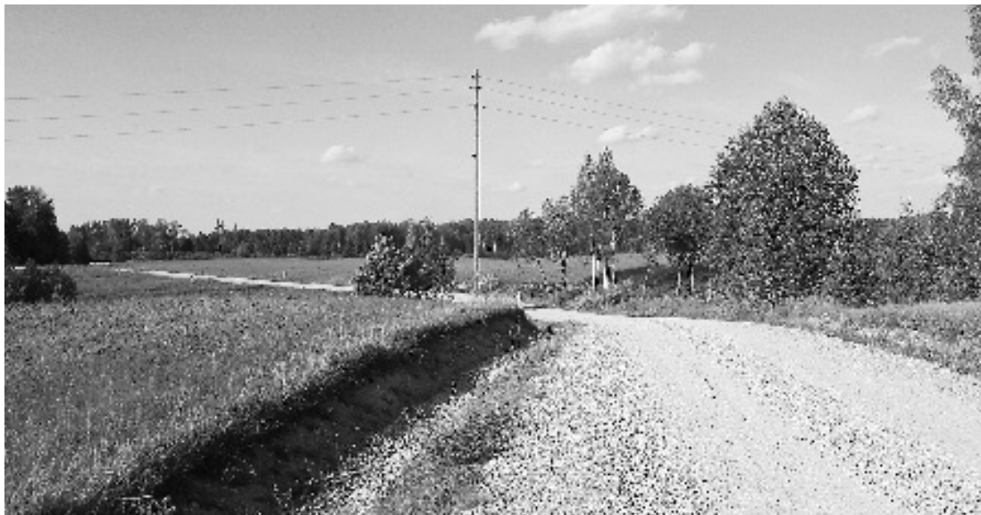
■KALNAINS, LĪKUMOTS UN SKAISTS. Ceļa Kapi – Veģeri – Veclaicenes šoseja pārbūvētais posms izmaina arī ainavu.
